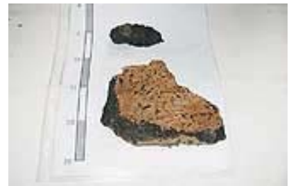
Detailaufnahme grobkörniger Gussasphalt
