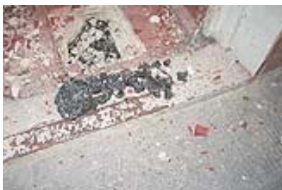
Gussasphalt (schwarz) unter Fliese und Estrich
