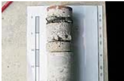
Bohrkern einer Geschosdecke mit (von oben nach unten): Fliese, Estrich und PAK-haltiger Isolierschicht (schwarz)
