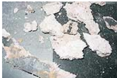
Detailaufnahme Magnesiaestrich (rosa) unter Floorflex-Platten
