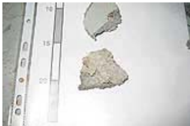
Detailaufnahme Magnesitestrich mit grauem Schutzanstrich
