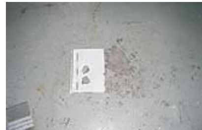
Magnesitanstrich (PAK- und MKW-haltig) mit grauem Schutzanstrich
